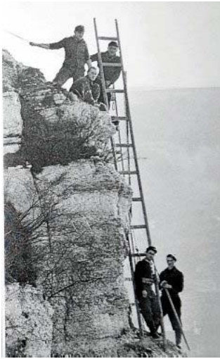
Hangsicherung am Wachtberg in den 1950er Jahren. Foto: aus: „Camburg. Bilder einer Kleinstadt“
