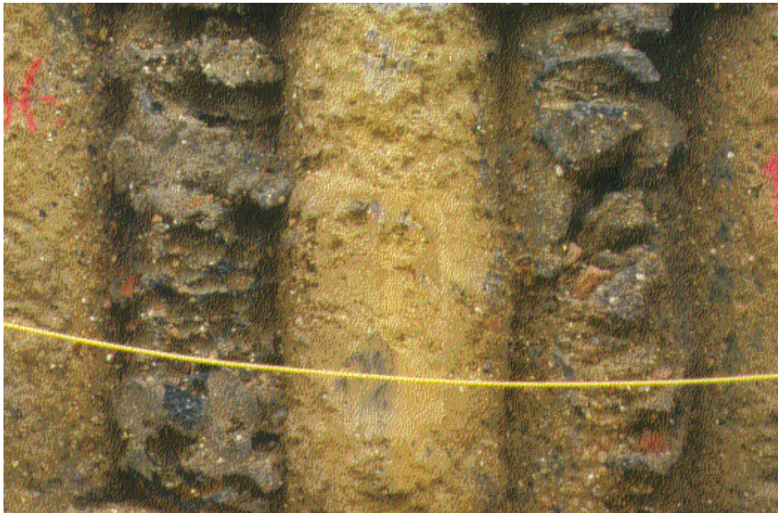
Bild 3: Sohlaufbrüche bei Schneckenbohrpfählen unter GW
